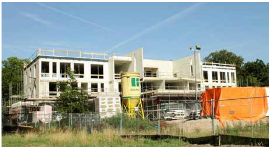
Vorderingen van de bouw begin augustus 2015
