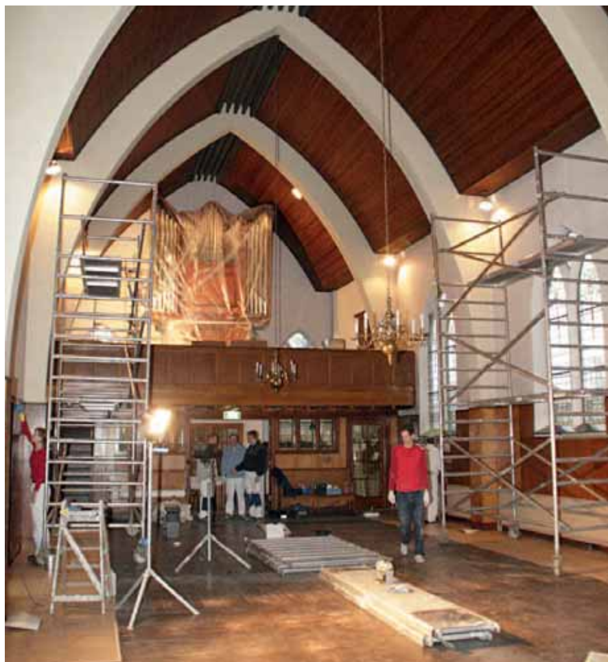
De Evangelisch-Lutherse kerk te Ede tijdens verbouwwerkzaamheden.
