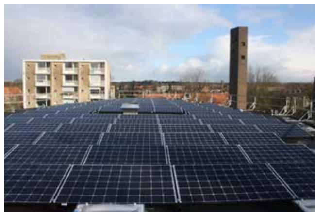
Zonnepanelen op de kerk voor de energievoorziening van de buurt
