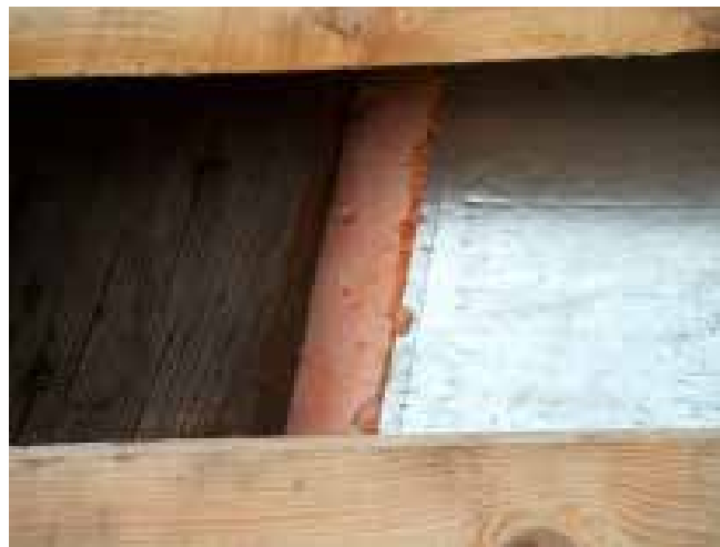
Detailopname van de aansluiting tussen het isolatiemateriaal en de ribben, na uitharding wordt het overtollig folie en schuim weggesneden (foto: Marc Stappers, 2004)
