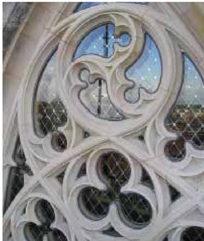
Glas-in-lood en de voorzetbeglazing (foto: Paul Rietbroek, 2006)
