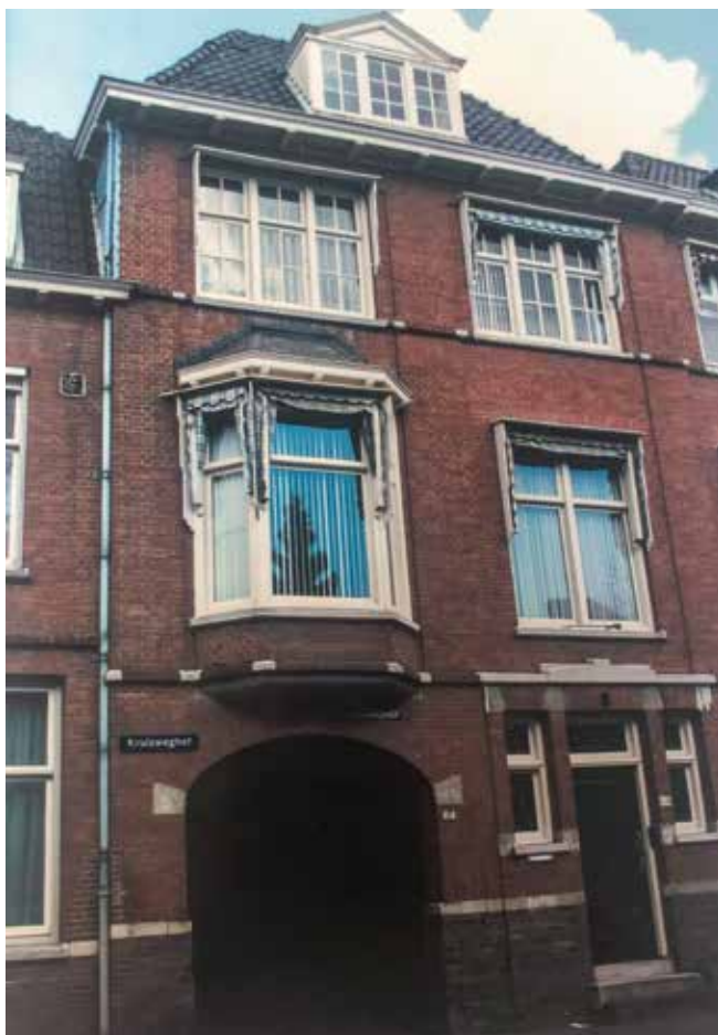
Het pand aan de Ferdinand Bolsingel 119 te Dordrecht waar van 1969 tot 2005 het Centraal Bureau van de Vereniging gevestigd was.
