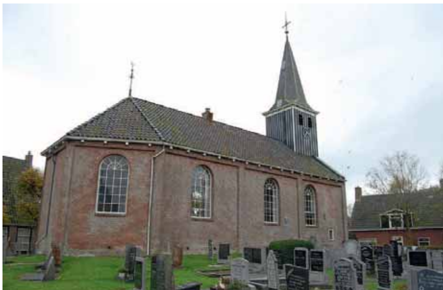
Kerkgebouw te Poppingawier.
