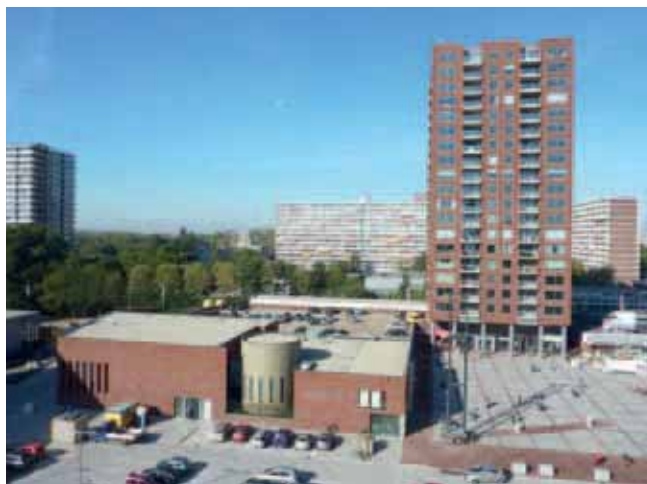
Overzichtsfoto met daarop het nieuwe gebouw
