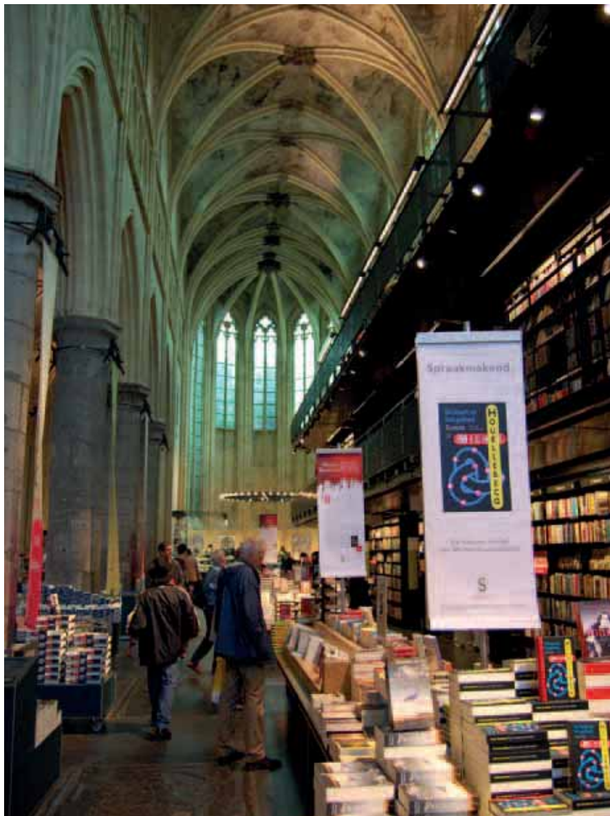
De voormalige Dominicanen kerk in Maastricht is in gebruik genomen door boekhandelketen Selexys. Om het vloeroppervlak te vergroten zijn twee tussenvloeren in het schip aangebracht. De bezoekers kunnen vanaf deze boekenflat niet alleen de boeken, maar ook de plafondschilderingen van dichtbij bekijken.
