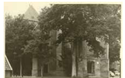
De ingang in het koor van de hervormde kerk te Hellendoorn, vóór de restauratie in het begin van de jaren '60
