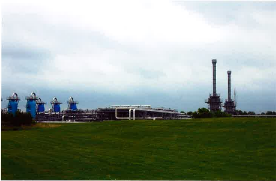
De veranderende structuur in 'het 'Olde Lantschap'. Installatie voor ondergrondse gasopslag te Langelo (een dorpje tussen Norg en Roden).
