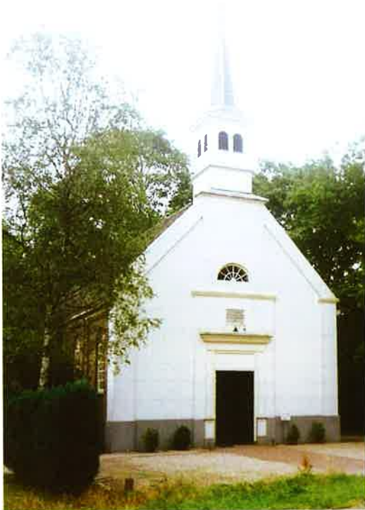
Kerkgebouw in Wilhelminaoord.
